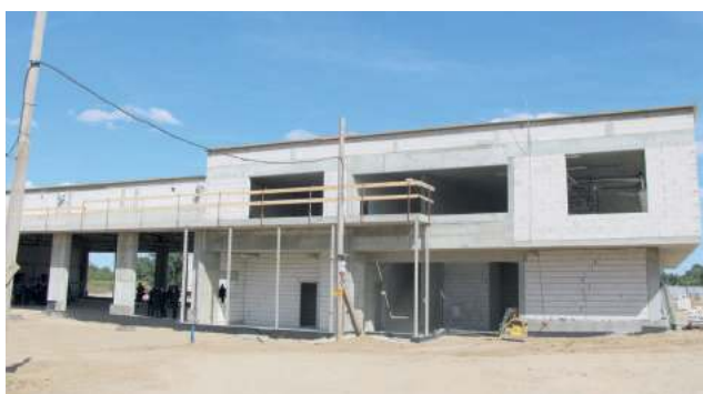
Budynek komendy w stanie surowym już stoi, prace trwają od stycznia
