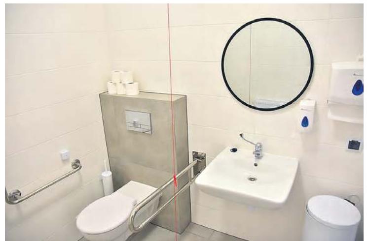
Czerwony sznureczek na pierwszym planie to część systemu umożliwiającego wezwanie pomocy. Po pociągnięciu w budynku załącza się głośny alarm.
