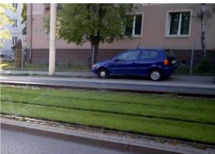
Fot. 4. Budowanie „zielonych torowisk” pozwala zmniejszyć hałas tramwajowy.
