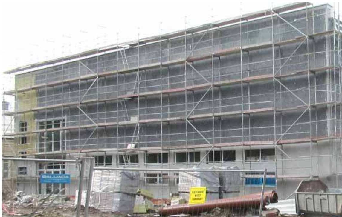
Plac budowy 3 lutego br.
