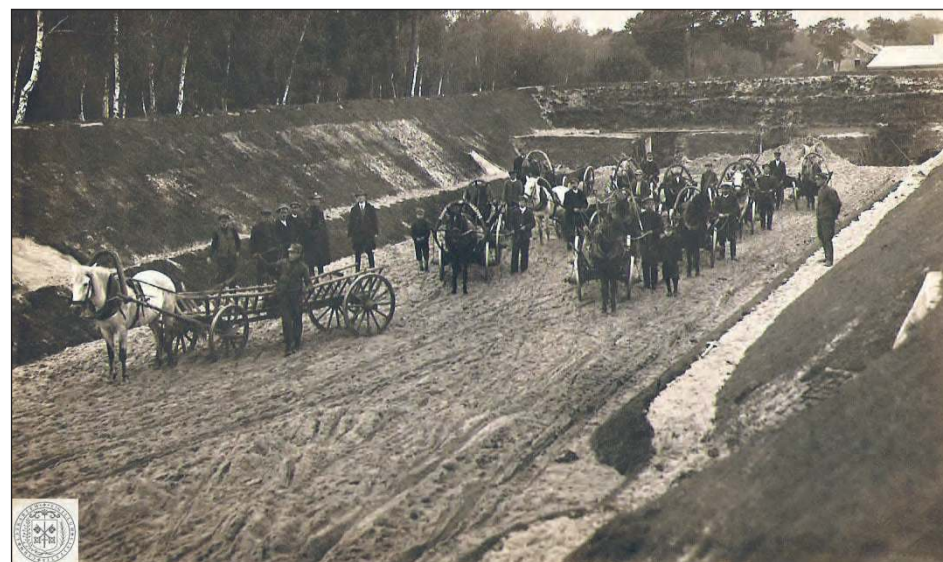
➤ Budowa strzelnicy w Łaskarzewie na obecnym boisku „Rycerska”, 1934 rok. Pobudowane zostały również ziemianki/schrony. Na zdjęciu widać cztery wejścia. Trzy widoczne są na tylnej ścianie i jedno po prawo. Zdjęcie wykonał fotograf Jan Jaworowski, który miał tytuł mistrza dyplomowanego (zdjęcie udostępnił z archiwum rodzinnego Bogusław Jaworowski)
