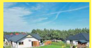
Dom przy ulicy Wyzwolenia, pow. 157,60 m 2 , 604 494 489
