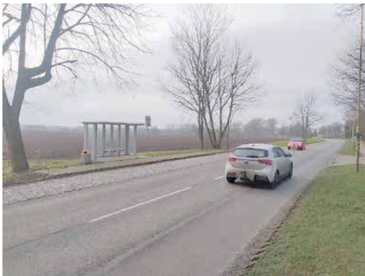
Z zatoki autobusowej przy Bohaterów Warszawy nie ma obecnie wytyczonego przejścia
