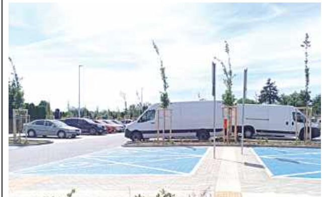
Dokonano już odbioru parkingu przy ul. Szaniawskiego na 104 miejsca
