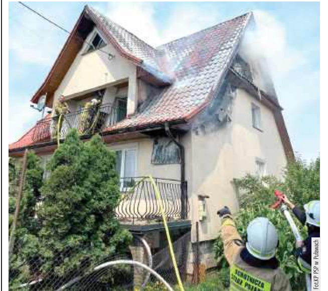
Ogień pojawił się na poddaszu budynku. Z pożarem walczyło kilka zastępów straży pożarnej
