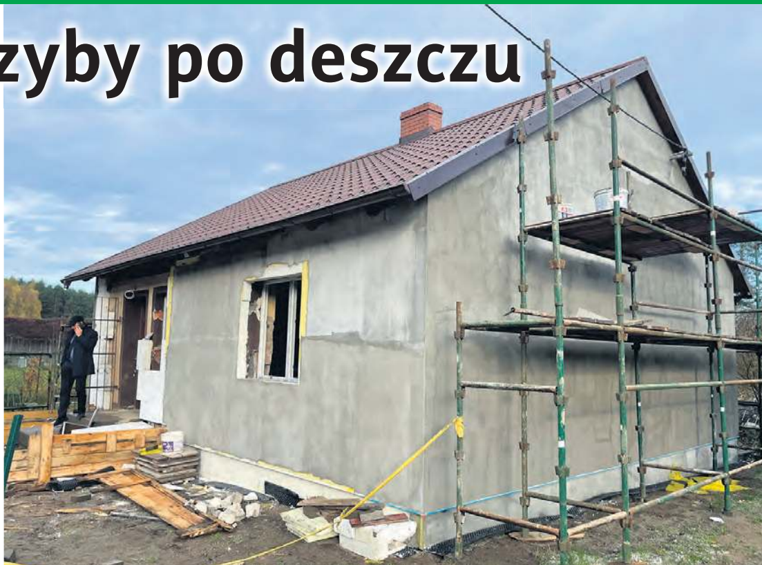
Zaawansowane prace trwają w Byłyczku.
