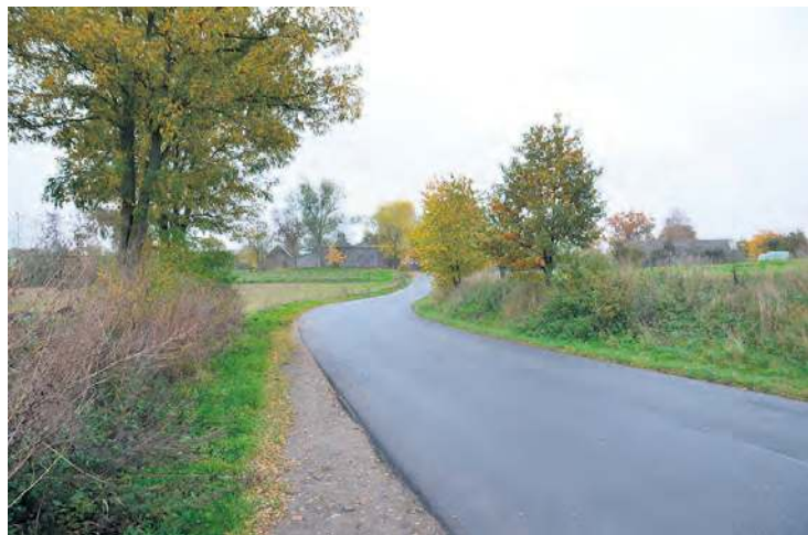
Patrząc od strony drogi na wybudowanie chodnik powstanie po lewej stronie jezdni.
