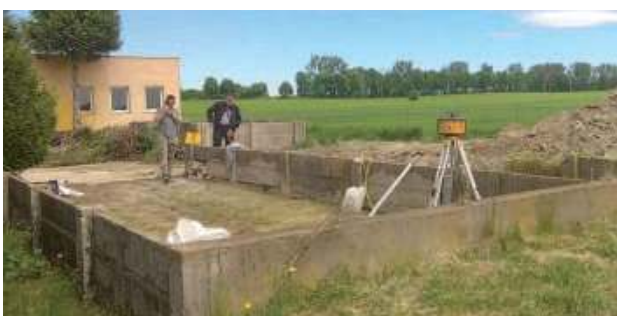
Prace już trwają. Inwestycja została dofinansowana z Europejskiego Funduszu Rolnego w ramach Programu Rozwoju Obszarów Wiejskich na lata 2014-2020. Chodzi o działanie „podstawowe usługi i odnowa wsi”
