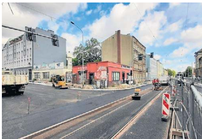
Obecny stan skrzyżowania Milczańskiej i Powstańców
