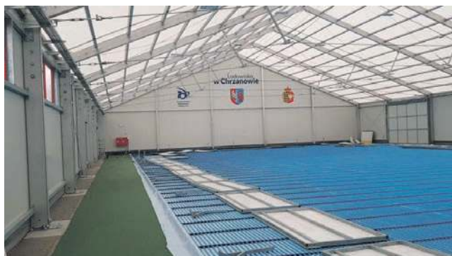
Chrzanowskie lodowisko gotowe do eksploatacji
