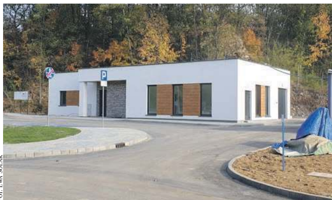
Budynek administracyjny, służący obsłudze strefy
