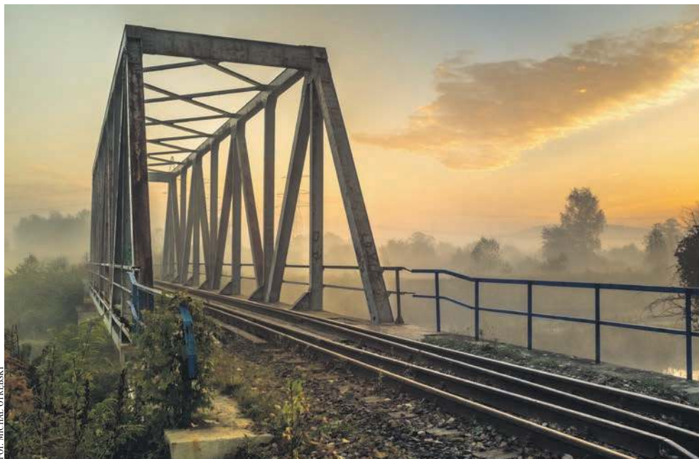
Most kolejowy nad rzeką Przemszą w rejonie Jelenia i Dzieckowic
