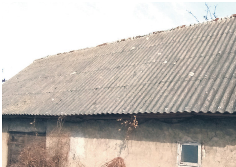
Na wielu budynkach leży jeszcze eternit.
