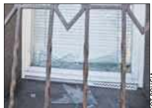
37-latek uszkodził okno i drzwi budynku, gdyż jego znajoma nie chciała go wpuścić do środka
