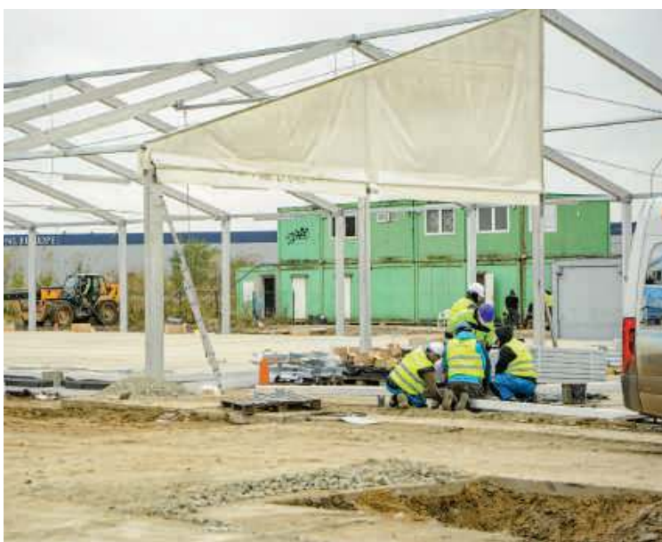
Budowa szpitala tymczasowego przy ul. Rakietowej we Wrocławiu
