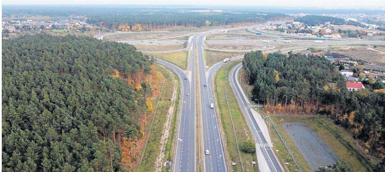
11 firm chciałoby zbudować 19,5 km S10 z Nakła nad Notecią do węzła Bydgoszcz Zachód (na zdjęciu)
