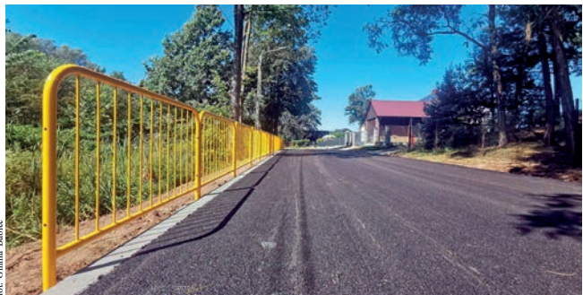
Nowy asfalt przy ulicy Floriana
