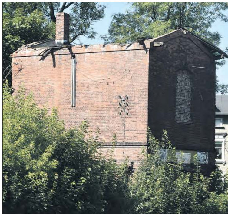
Na budynku zawalił się już dach. Na ścianie widać drewniany miernik poziomu wody w zbiorniku, który był umieszczony w górnej części budowli.
