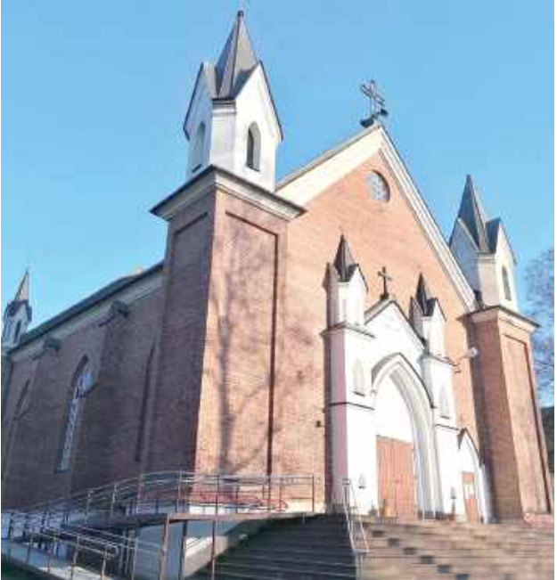
Do remontu dołożyła się gmina (4 600 zł) oraz parafia (koszt inspektora nadzoru - 2 500 zł)
