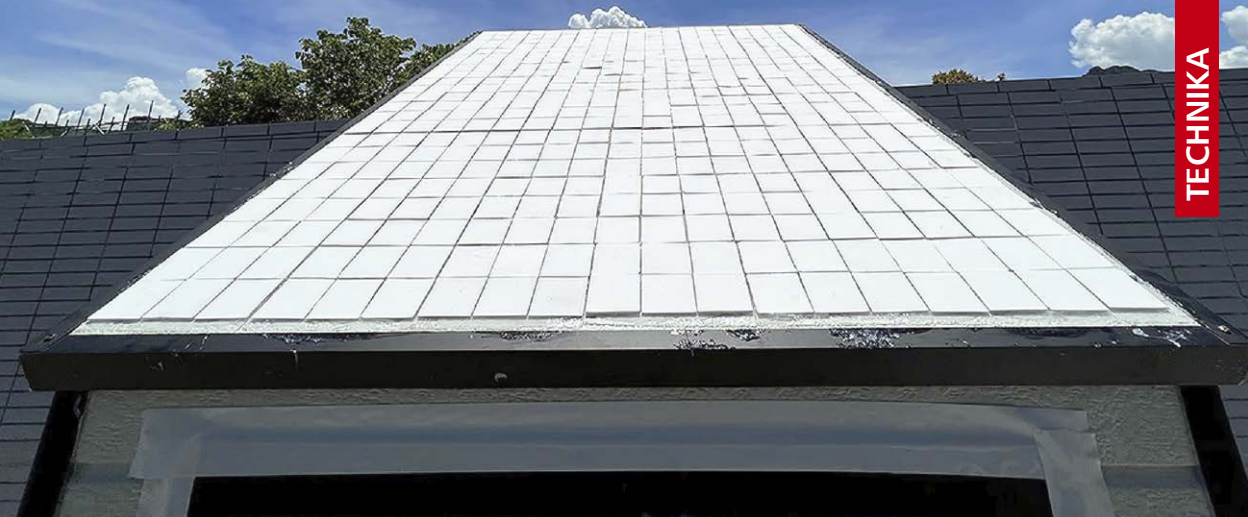
1. Prototypowa powłoka dachu z materiału inspirowanego chrząszczami
