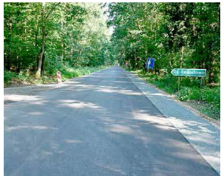
Przebudowywana droga łączy się z drogą gminną prowadzącą do miejscowości Redostowo
