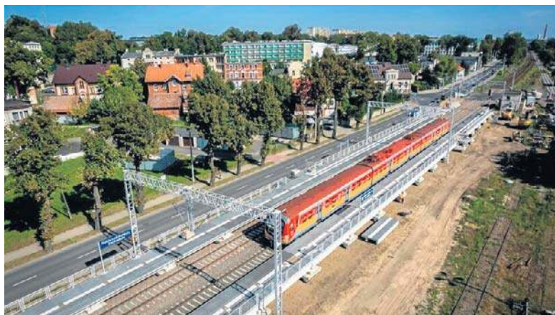
Nakło Zachodnie - przystanek budowany jest przy linii kolejowej Kutno - Piła Główna, w sąsiedztwie przejazdu kolejowo-drogowego
