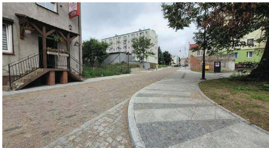
Dobiega końca przebudowa ulicy Kruczej
