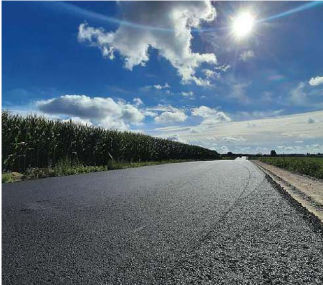
Fot. Jedna z wyremontowanych dróg powiatu lidzbarskiego, od miejscowości Gronowo do miejscowości Zagony, w gminie Lubomino
