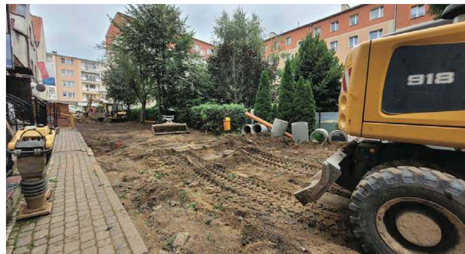
Prace trwają na ulicy Milewicza
