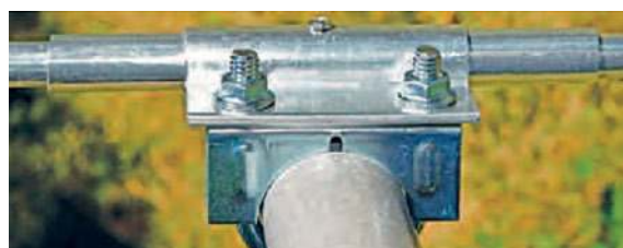
Fot. 2. Montaż elementów do nośnika
