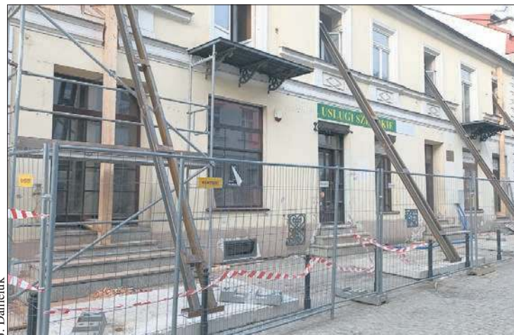
Przy remoncie kamienicy przy ul. Grodzkiej 8 stanęły zabezpieczające podpory
