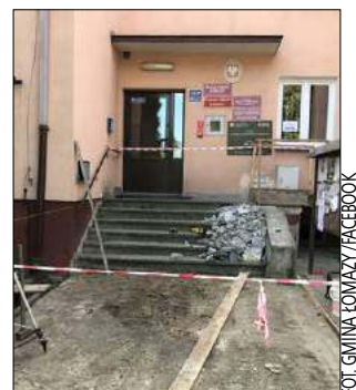
Przy budynku urzędu gminy w Łomazach trwają prace. Montowany jest podjazd dla osób niepełnosprawnych. Osoby te będą miały też miejsce parkingowe
