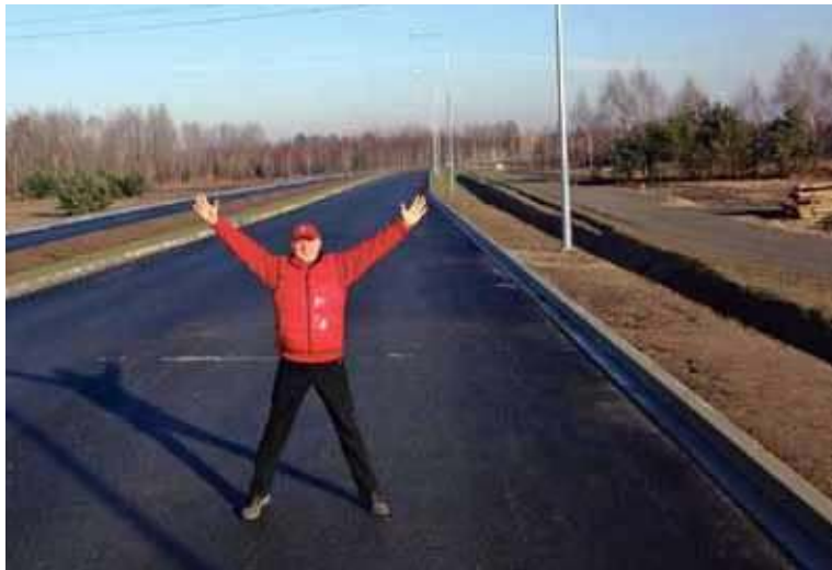
Senator Wadim Tyszkiewicz na terenie budowy południowej obwodnicy. Zdjęcie archiwalne (fot. FB Wadima Tyszkiewicza)
