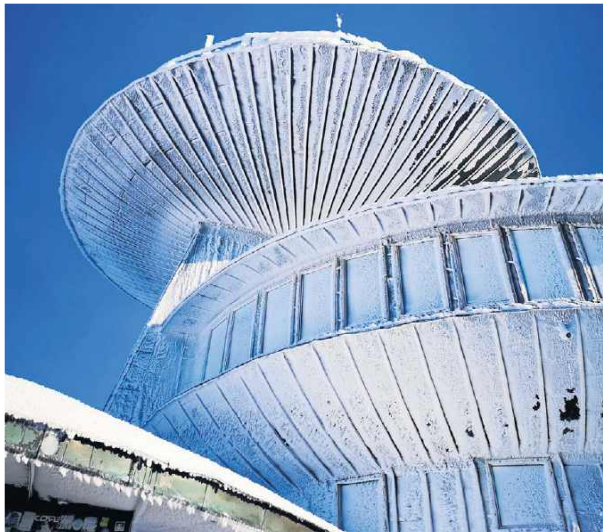
Śnieżka i obserwatorium na jej szczycie robią wrażenie o każdej porze roku
