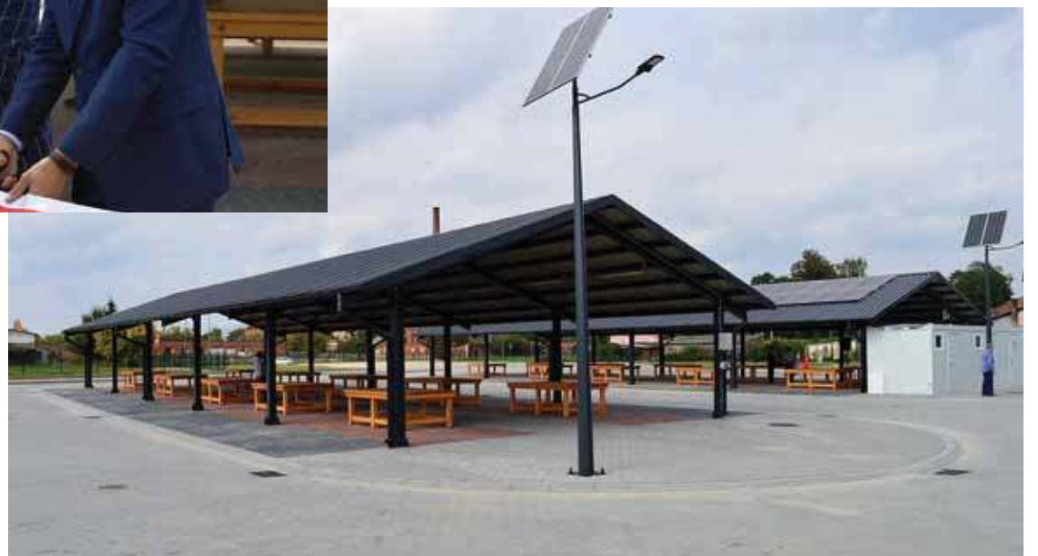
Zmodernizowany obiekt posłuży lokalnym handlarzom i społeczności.
