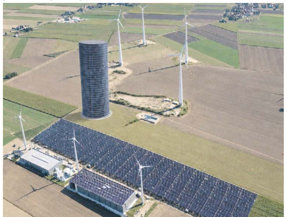
Wieża w Gaju Oławskim będzie wyższa i grubsza niż wrocławski Sky Tower
