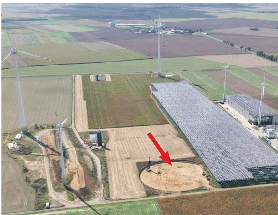
Budowa już ruszyła - tu będzie podstawa pierwszej wieży
