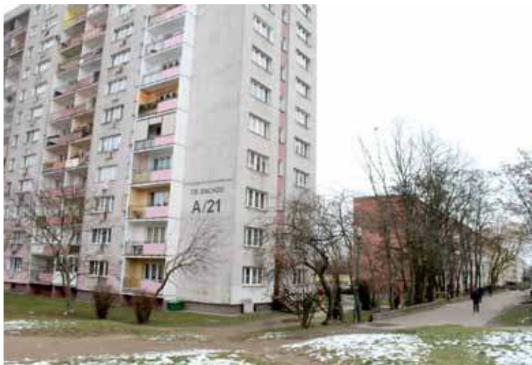
Budynek A 21 wymaga doprowadzenia drogi pożarowej, gdyż aktualnie zapewniony jest dostęp tylko do ok. 43 % obwodu budynku
