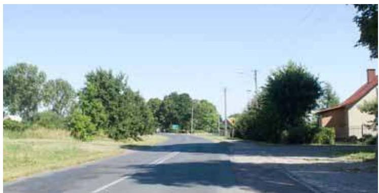
Gmina Stara Dąbrowa uzyskała dofinansowanie z Powiatu Stargardzkiego i Rządowego Funduszu Dróg na przebudowę drogi w Starej Dąbrowie
