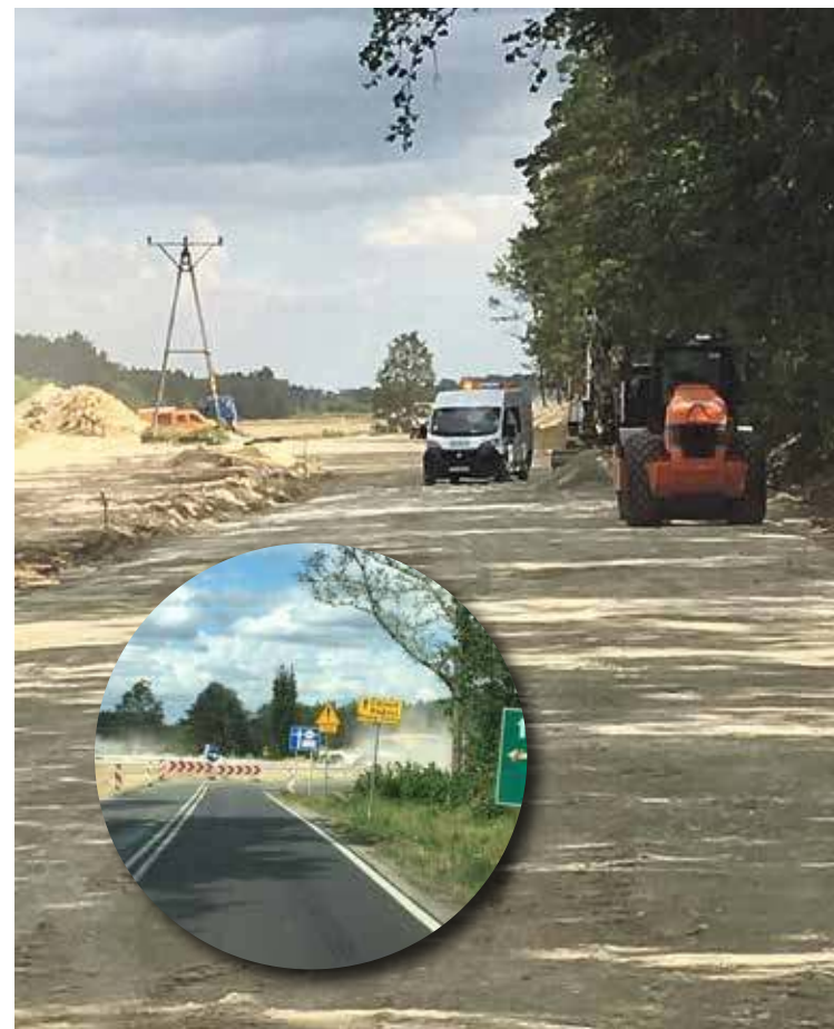
Droga była bardzo niebezpieczna, dochodziło tu do wielu śmiertelnych wypadków. Budowa ronda, ma poprawić bezpieczeństwo.
