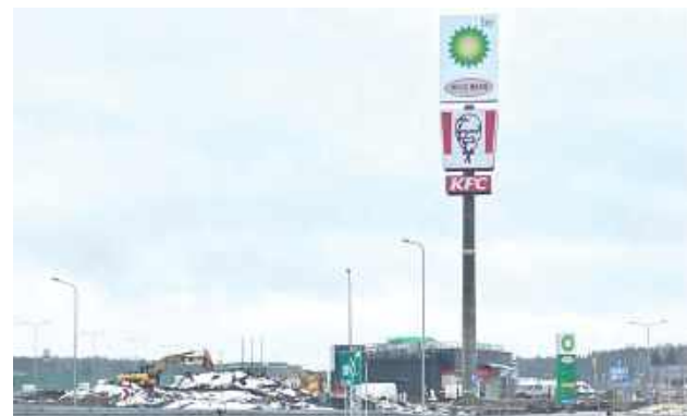
Prace budowlane na terenie MOP Pilawa wciąż trwają
