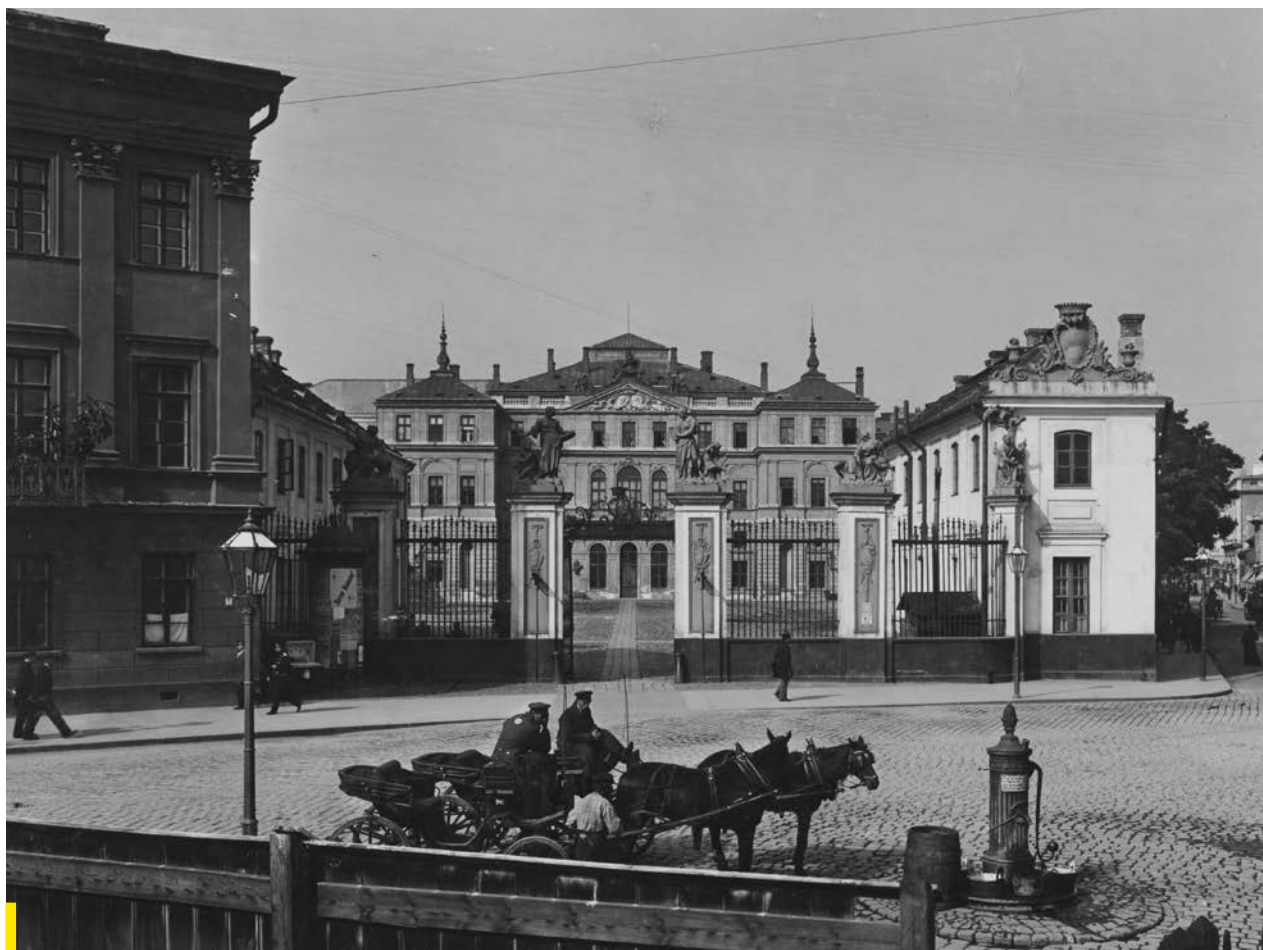
Pałac Brühla, początek XX wieku, źródło: Polona
