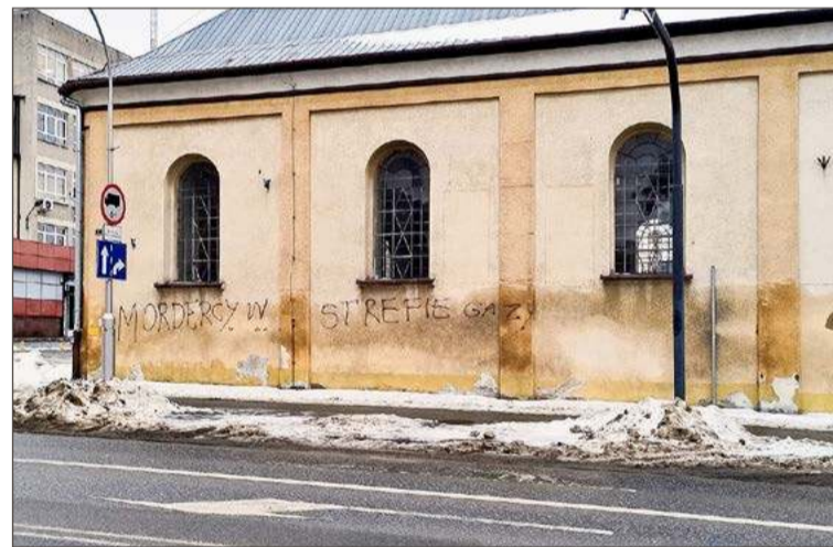
Napis wykonany został na frontowej ścianie zabytkowej synagogi.
