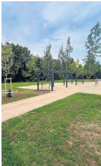
Prace są na ukończeniu
