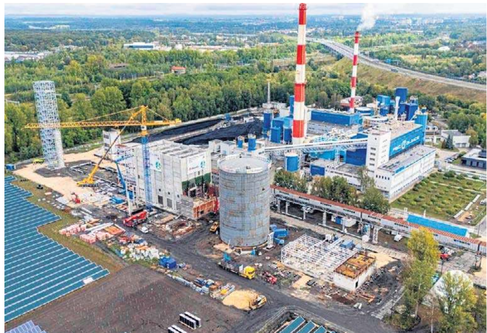
Na terenie budowy przy ul. Królewskiej Tamy symbolicznie zaznaczono kolejny etap
