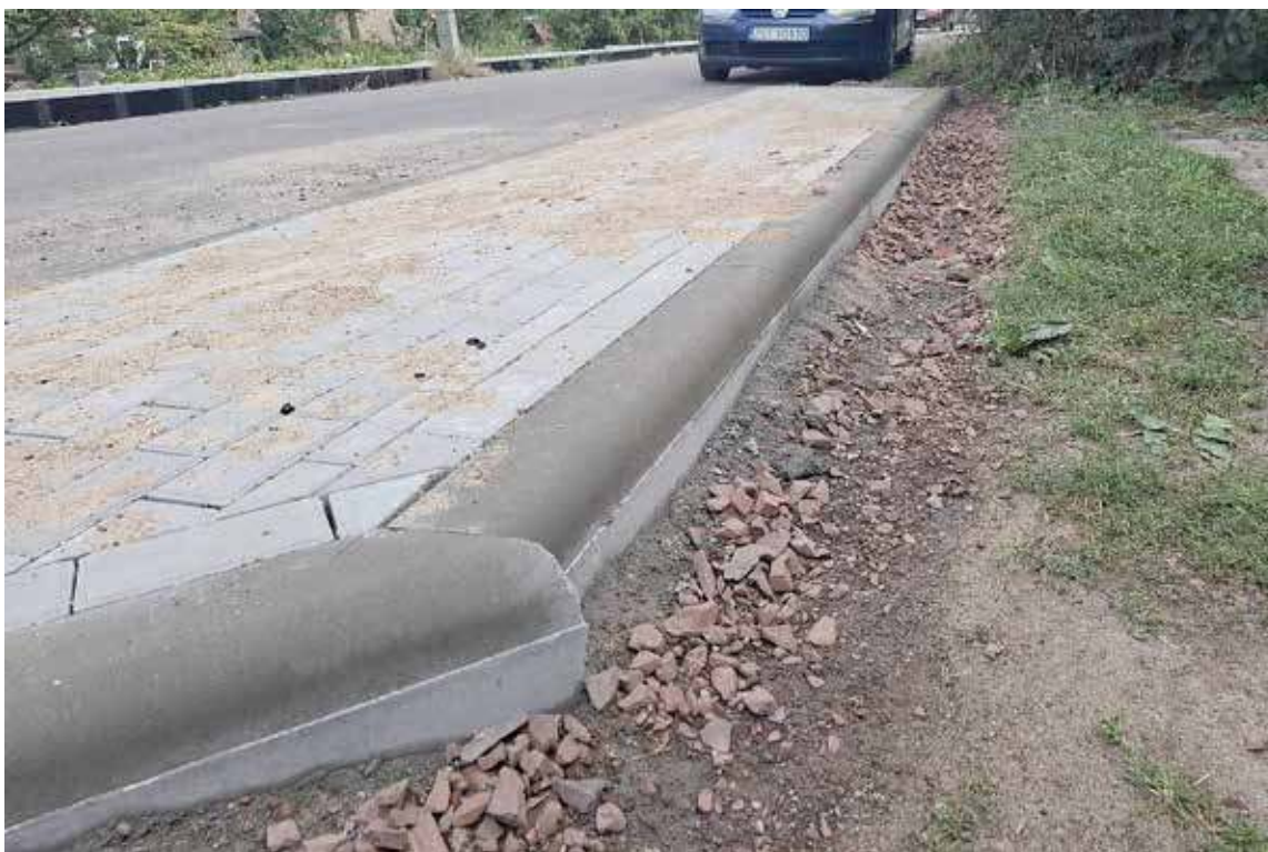
Tak z bliskiej perspektywy wyglądają krawężniki na przebudowanej drodze w Skalinie
