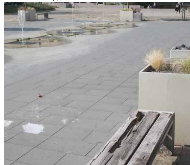
Niektóre ławki przy fontannie wymagają już naprawy
