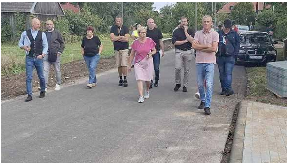
Przypomnijmy, we wtorek 10 września przybyła do Skalina komisja (rada budowy). Mieszkańcy skarżyli się na wadliwie wykonaną drogę
