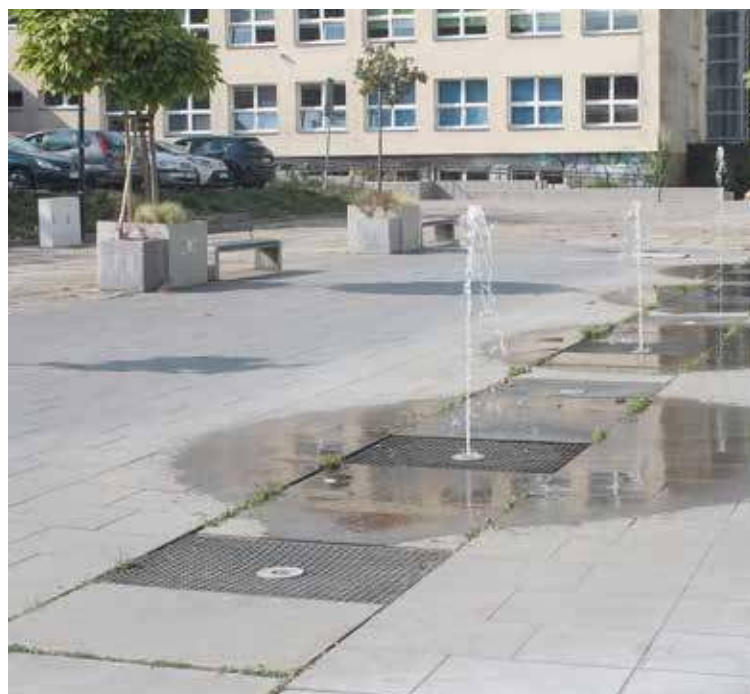
Częste awarie fontanny spowodowane są ich niewłaściwym użytkowaniem poprzez m.in. wrzucanie kamieni, co powoduje duże uszkodzenia sprzętu
