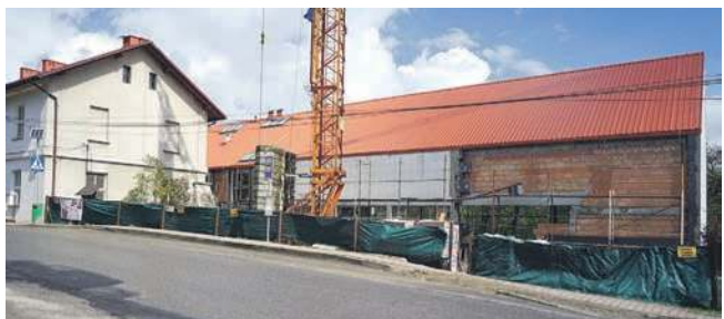
Budowana sala gimnastyczna przy szkole w Grojcu
