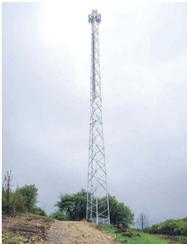
Maszt firmy Play na wzniesieniu przy Chrzanowskiej na osiedlu Siersza w Trzebini
