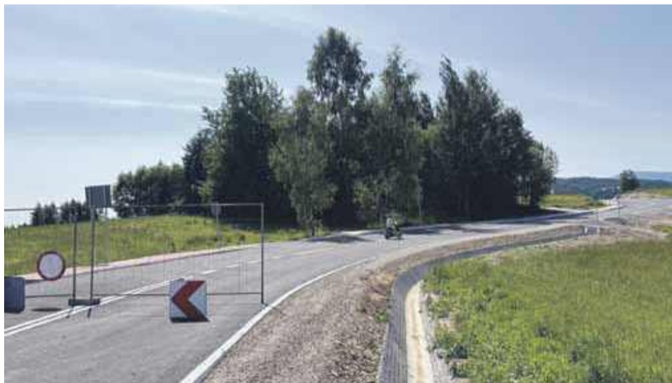
Piękny asfalt w miejscu dotychczasowej drogi gruntowej.
