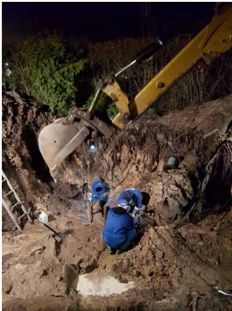
Od piątku do niedzieli pracownicy WOZ usuwali awarię sieci wodociągowej w Grzędzicach
