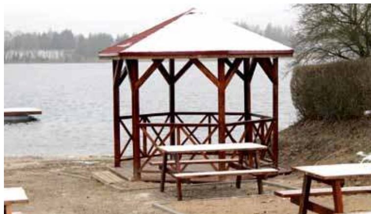
Postawiono również drewnianą altanę.
