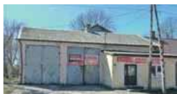
Budynek w centrum Wisznic przed rewitalizacją
