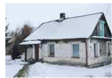
Budynek socjalny w Wisznicach przed rewitalizacją
