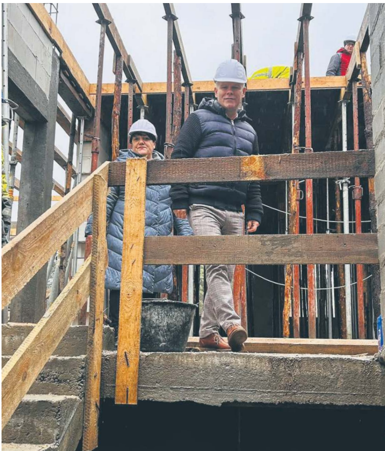
Wójt Marcin Zawadka na terenie rozbudowywanej szkoły w Liszynie
