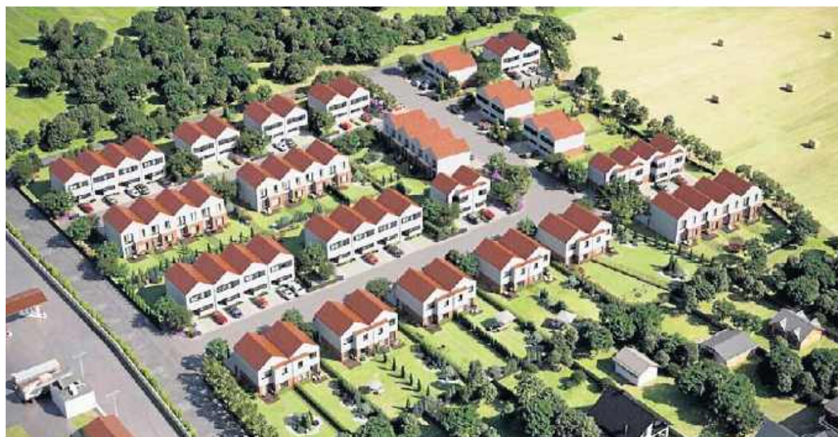
FOT. BESTEL HOUSE
