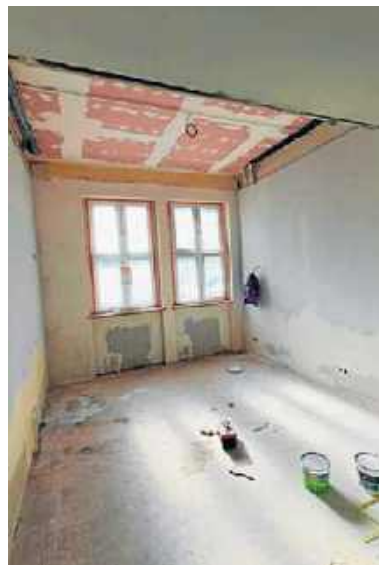
FOT. SZPITAL WĄGROWIEC
