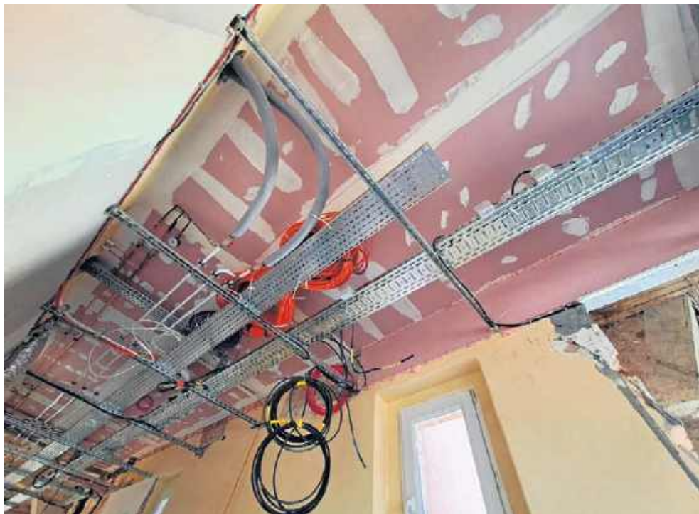
Modernizacja i rozbudowa szpitala w Wągrowcu.
