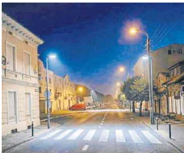
Inwestycja dotyczy poprawy widoczności na przejściach dla pieszych przy ul. Gnieźnieńskiej.
