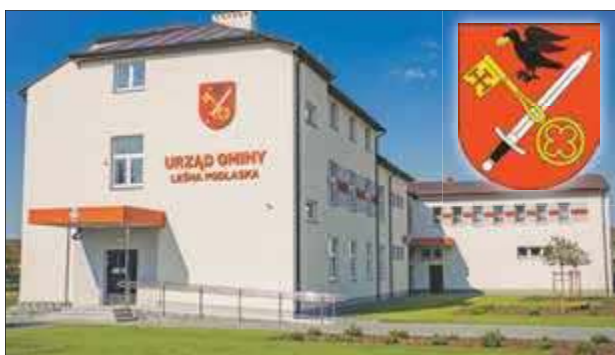
Sztandarową inwestycją połowy obecnej kadencji wójta Pawła Kazimierskiego był projekt dotyczący „Termomodernizacji budynków użyteczności publicznej”
