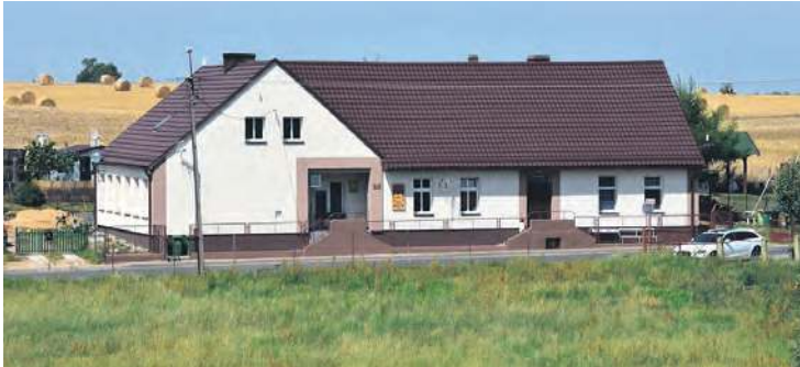
Przyrowa – w budynku znajduje się m.in. świetlica wiejska.
