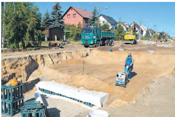
Tuż przy powstającym utwardzeniu drogi powstaje rozsączalnik wód opadowych.
