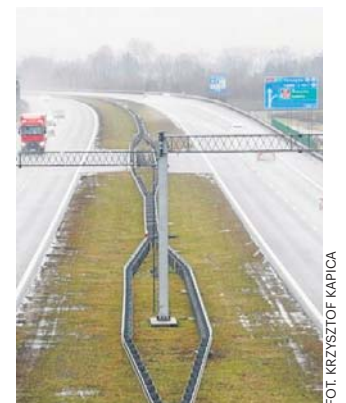
Remont potrwa do października
