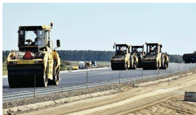
Budowa drogi S5 Ostróda — Nowe Marzy
