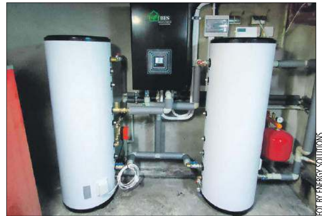
By Energy Solutions zajmuje się m.in. montażem pomp ciepła
