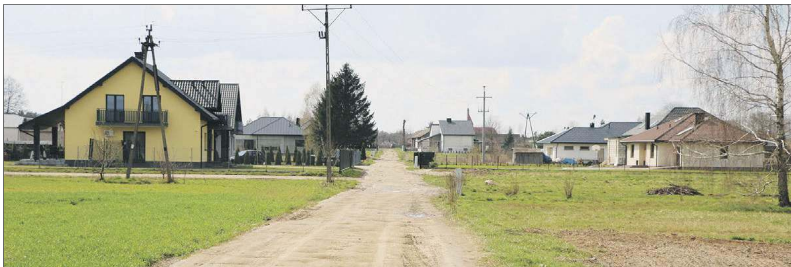
Na utwardzenie ulicy Świerkowej w Czosnówce mieszkańcy czekają od kilku lat
