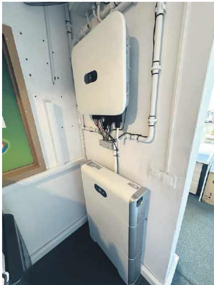
Na dole magazyn energii o pojemności 10 kWh, nieco wyżej falownik.
